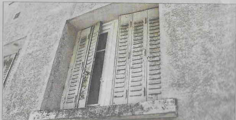
■ Les volets rouillés de la résidence Les Creuses. Photo Geoffrey Gaye
